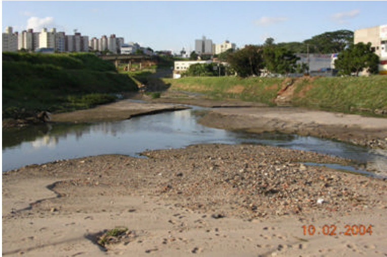
Foto 5. Confluência do córrego Proença com o córrego da Orosimbo Maia , no início do ribeirão Anhumas: assoreamento, degradação e risco de inundações. Data:10/02/2004.
