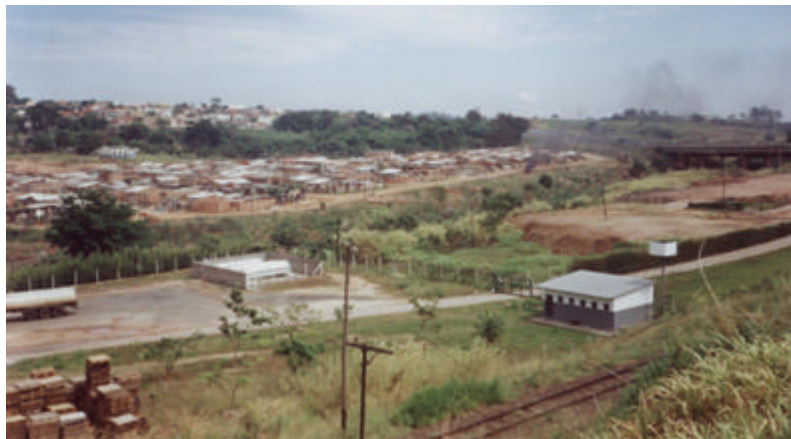
Foto 16. Ocupação Gênesis ao lado da rodovia D. Pedro I na margem esquerda do ribeirão Anhumas. Data: 25/11/2002.
