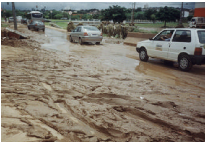
Foto 8. Via marginal ao córrego Brandina, após a enchente de 17/02/2003. Data 18/02/2003.
