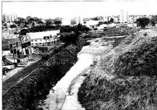
Av. Norte-Sul, na Chácara da Barra, onde os córregos Proença e Serafim se unem: inundações
