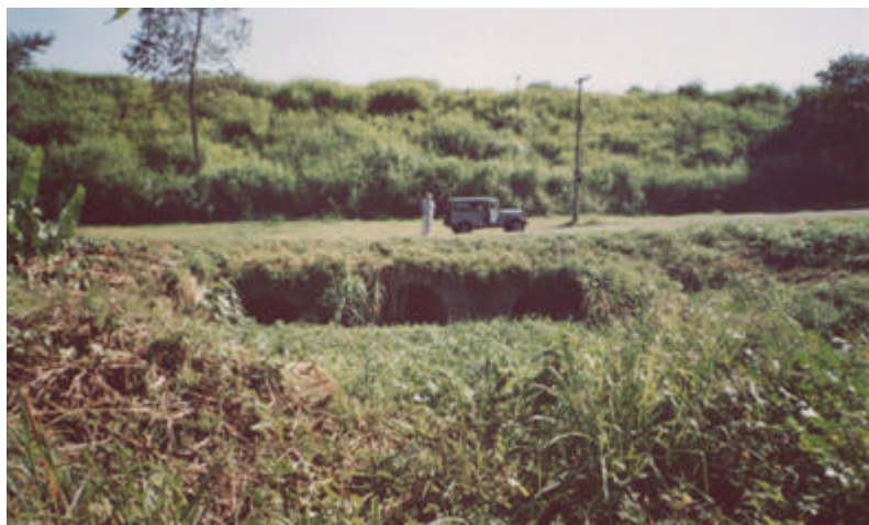
Foto 17. Tubulação do Córrego São Quirino, Parque Imperador: área de risco de inundações. Data:05/04/2004.
