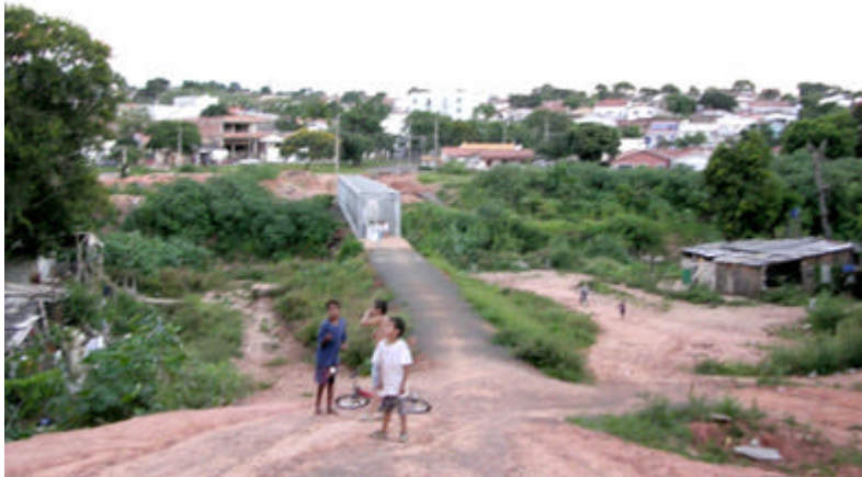
Foto 9. Adutora de água da Sanasa: favela Tubão ao longo do Anhumas. Data: 10/02/2004.
