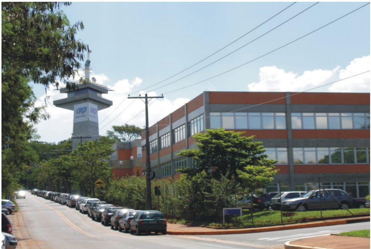
Fundação Centro de Pesquisa e Desenvolvimento em Telecomunicações - CPqD
