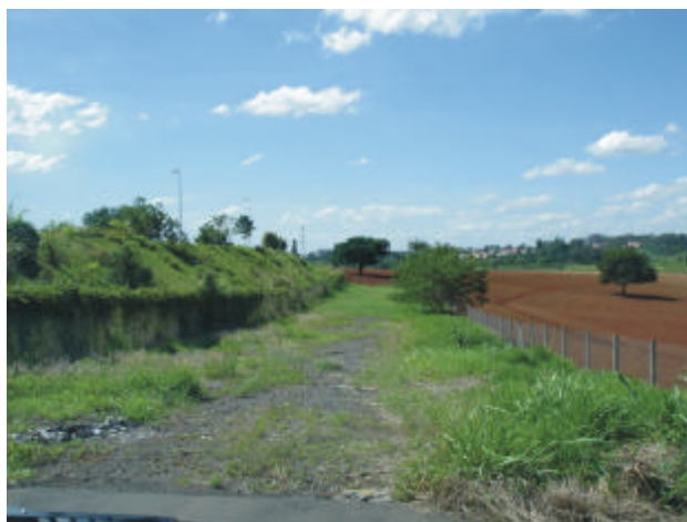
Prolongamento da Avenida de Contorno entre a Fazenda Pau d'Alho e a Promon
